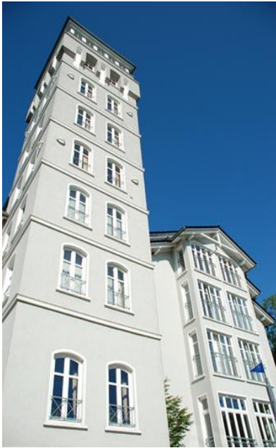
Turm Vju Hotel Rügen
